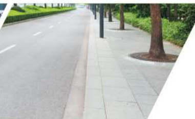
Réaliser des trottoirs et des enrobés en matériaux clairs
