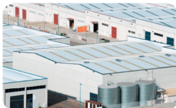
Logistique entrepôts, plateformes, data centers
